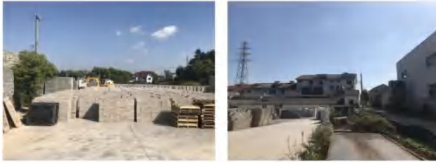
图3.4-1 踏勘时本地块现状图
