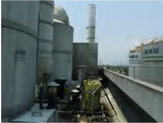
卸料平台废气处理装置
