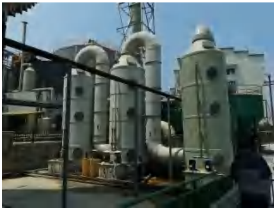
均质池、污水站废气目前和沼液处理废气处理装置及 DA003 排气筒
