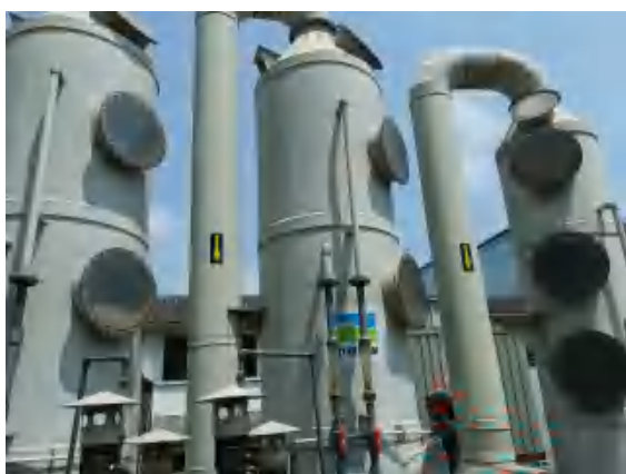
厌氧池废气处理装置及 DA004 排气筒
