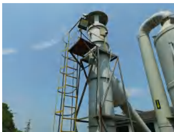
厌氧池废气处理装置及 DA004 排气筒
