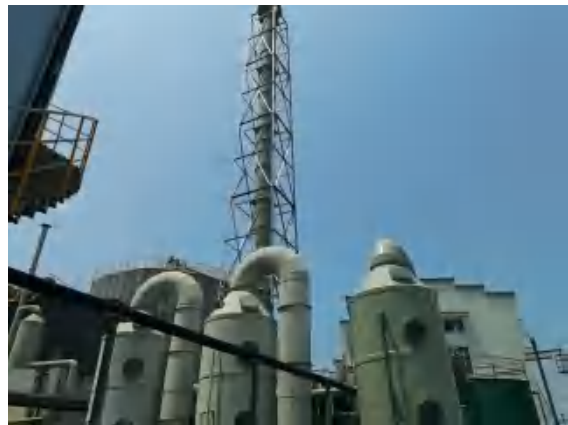
均质池、污水站废气目前和沼液处理废气处理装置及 DA003 排气筒
