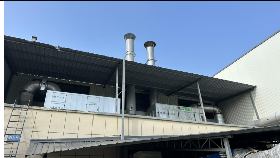
图 4-5 涂装废气（左）、挤塑废气和喷塑后固化废气（右）处理装置
