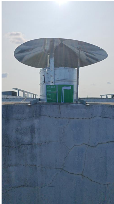
图 3-7 1#厂房 3 层车间DA002 排气筒实拍图
