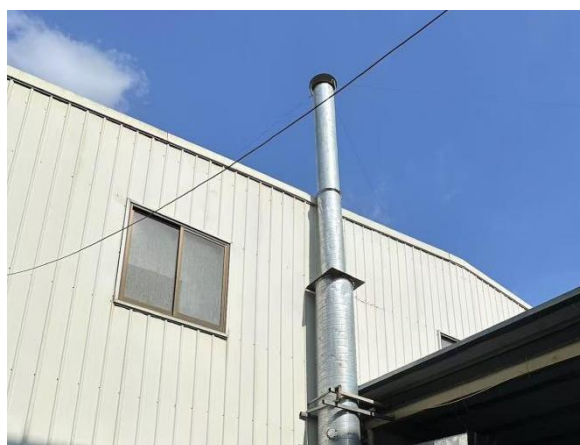
图 3-3 2#厂房 1 层车间活性炭吸附装置及排气筒DA001 实拍图
