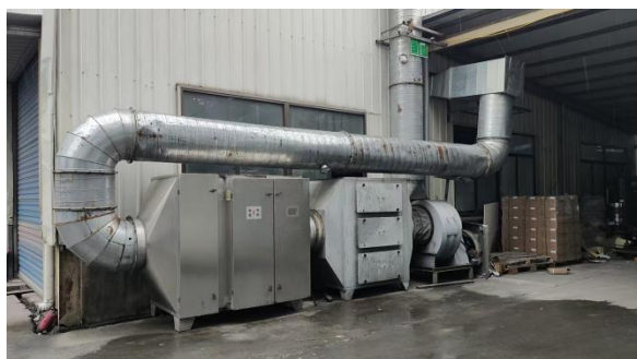
图 3-3 2#厂房 1 层车间活性炭吸附装置及排气筒DA001 实拍图
