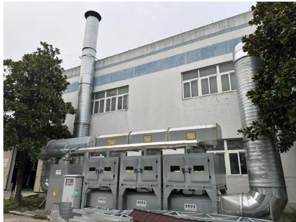
图 3-6 挥发废气及天然气燃烧废气处理措施及排气筒
