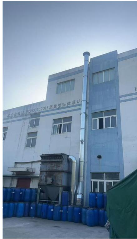
图 3-2 撒砂粉尘废气处理措施及排气筒
