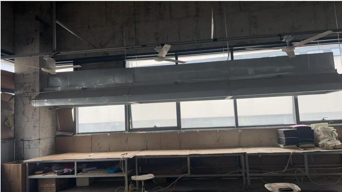
图 3-2 喷胶台集气罩实拍图
