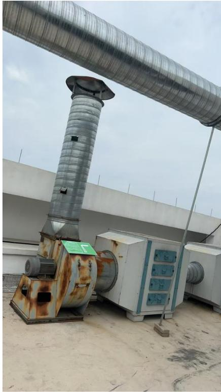
图 3-1 二级活性炭吸附装置及排气筒 DA001 实拍图
