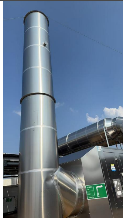
图 3-4.3 发泡、压纹废气处理装置、排气筒 DA007
