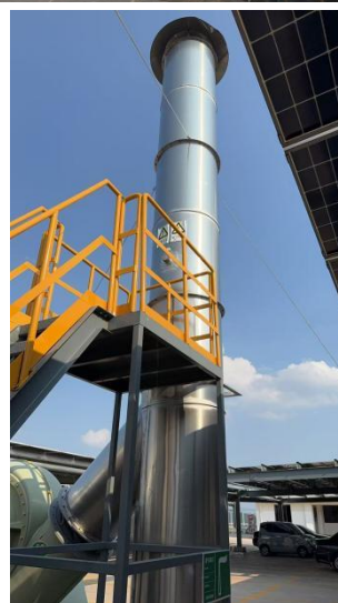
图 3-5 表面处理废气处理装置、排气筒 DA008、DA009
