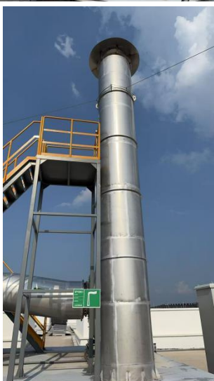
图 3-5 表面处理废气处理装置、排气筒 DA008、DA009
