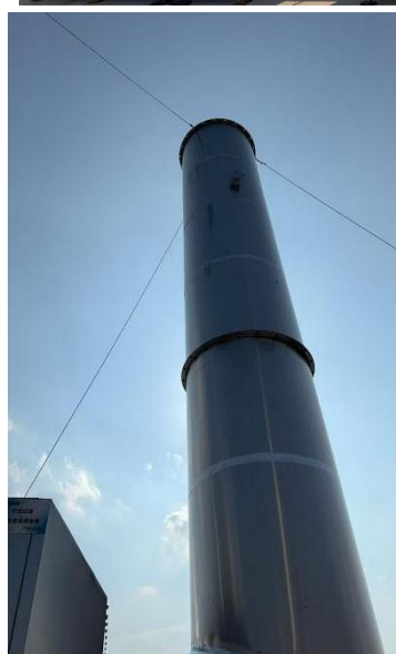
图 3-4.2 发泡、压纹废气处理装置、排气筒 DA006
