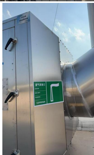
图 3-4.2 发泡、压纹废气处理装置、排气筒 DA006
