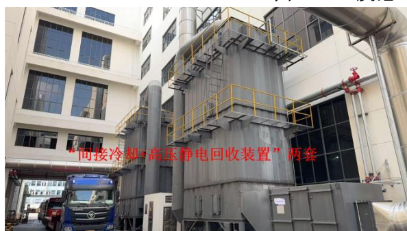
图 3-4.1 发泡、压纹废气收集装置
