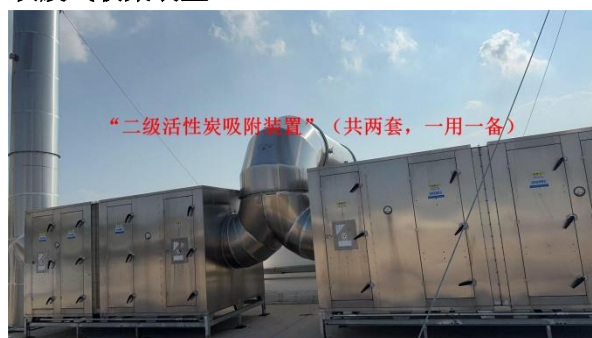
图 3-4.1 发泡、压纹废气收集装置
