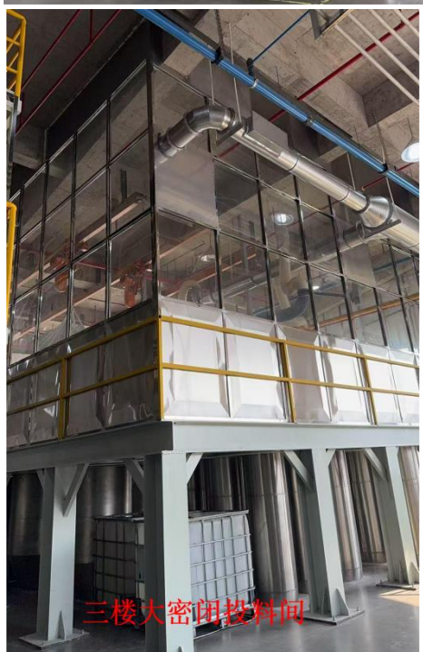
图 3-2.1 1#厂房投料粉尘收集与处理装置、排气筒 DA002
