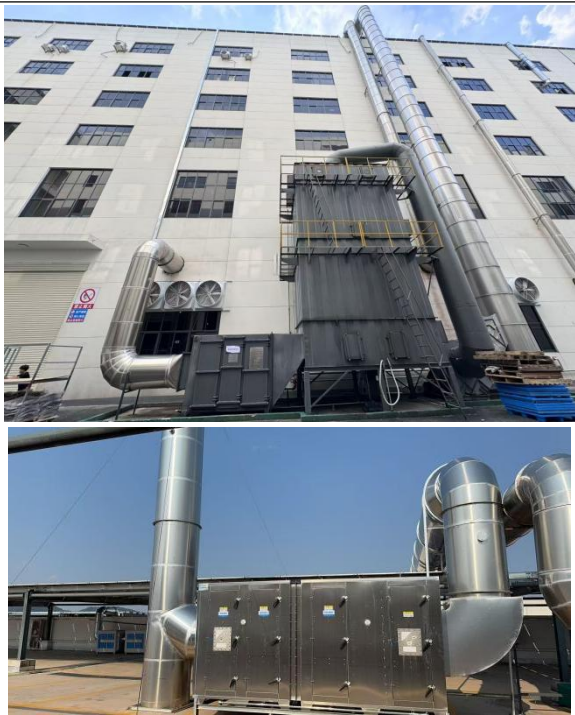
图 3-4.3 发泡、压纹废气处理装置、排气筒 DA007
