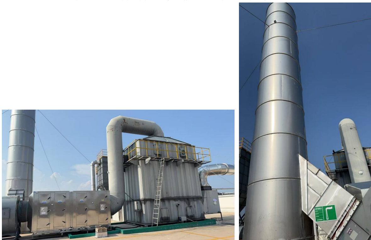
图 3-3.3 密炼开炼压延机组废气处理装置、排气筒 DA005
