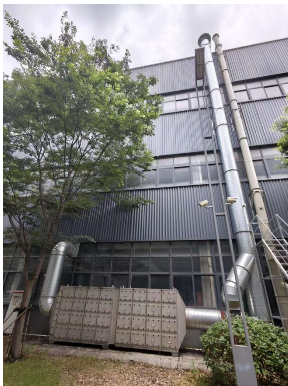
图 3-1 有机废气集气方式及排气筒 DA001 实拍图
