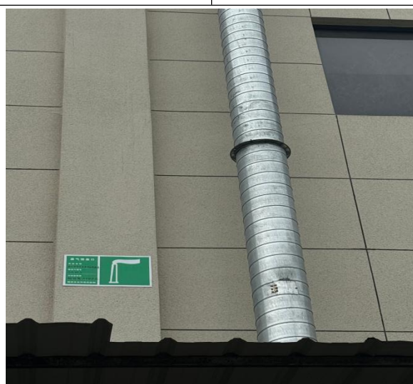
图 3-2 直缝高频焊接烟尘、刮刀粉尘、乳化液受热废气（钢管 7#生产线）收集+处理设施+排气筒（DA002）实拍图
