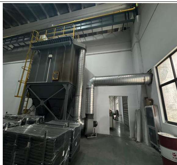
图 3-2 直缝高频焊接烟尘、刮刀粉尘、乳化液受热废气（钢管 7#生产线）收集+处理设施+排气筒（DA002）实拍图
