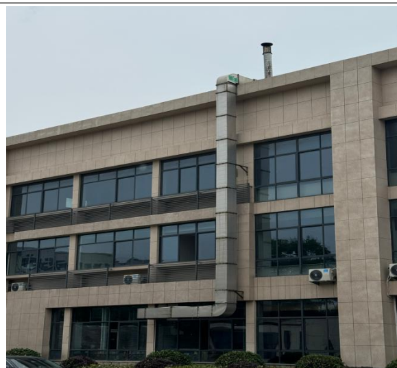
图 3-4 食堂油烟废气收集+处理设施+排气筒（DA004）实拍图
