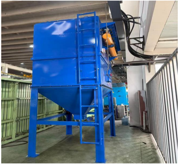
图 3-1 直缝高频焊接烟尘、刮刀粉尘、乳化液受热废气（钢管 1#-6#生产线）收集+处理设施+排气筒（DA001）实拍图
