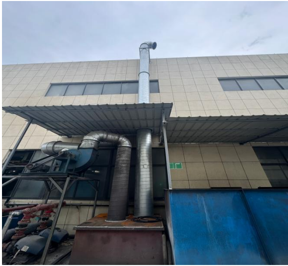
图 3-1 直缝高频焊接烟尘、刮刀粉尘、乳化液受热废气（钢管 1#-6#生产线）收集+处理设施+排气筒（DA001）实拍图
