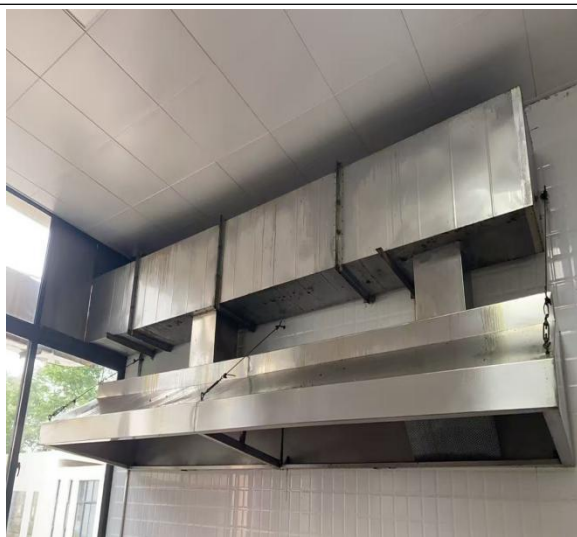
图 3-4 食堂油烟废气收集+处理设施+排气筒（DA004）实拍图
