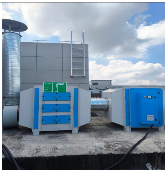
图 3-1 1#厂房三楼油雾废气处理措施+排气筒 DA001 实拍图
