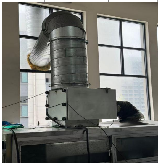
图 3-1 1#厂房三楼油雾废气处理措施+排气筒 DA001 实拍图
